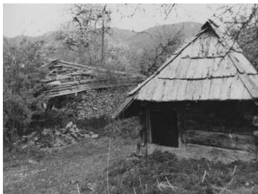
Porušena kuća Saliha Tahirovića u selu Čerjenci (Snimljeno 30. aprila 2002. godine)
